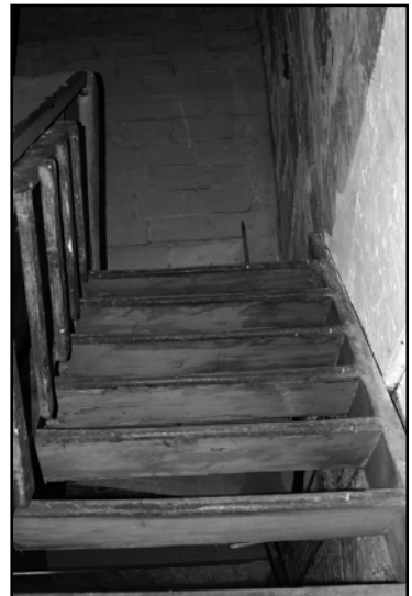
Escalera de acceso a planta alta
