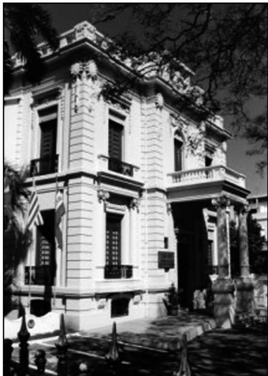
Ex Sede del SID "La Casona", Br. Artigas y Palmar, actual Sede del CALEN (Foto actual)
