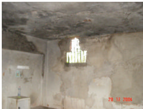
(foto 01: parede de outra cela com muita infiltração; foto 02: doentes jogados sob o chão úmido)
